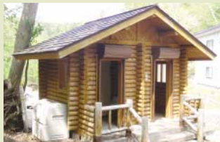
「木下小屋」前のトイレ
