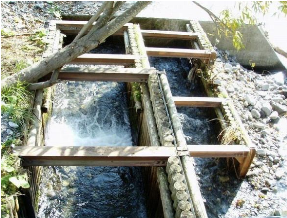
・魚道 改良前 (No.1 床固工)
