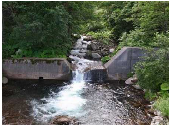
モセカルベツ川の治山ダム（北海道）
