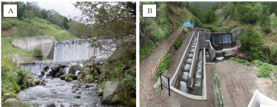
図4. ダム改良前後（魚道の新設） A：改良前、B：改良後
