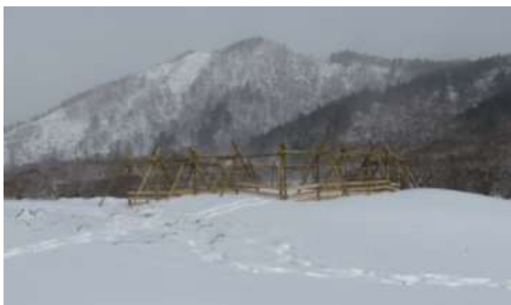
図2: 施工した自立式防風防鹿柵
