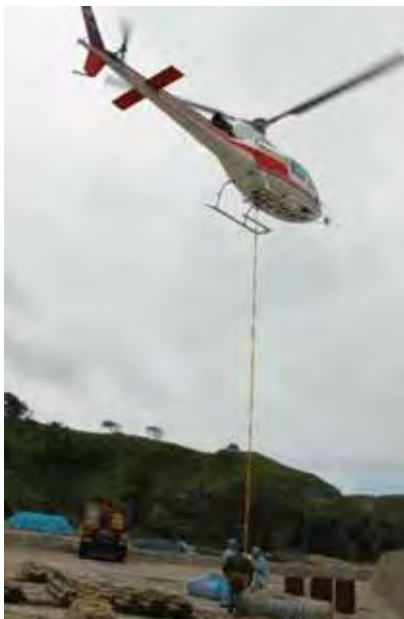
写真-11 7/2 文吉湾資材吊り上げ作業
