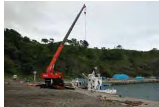
写真-10 7/2 文吉湾資材陸揚げ作業
